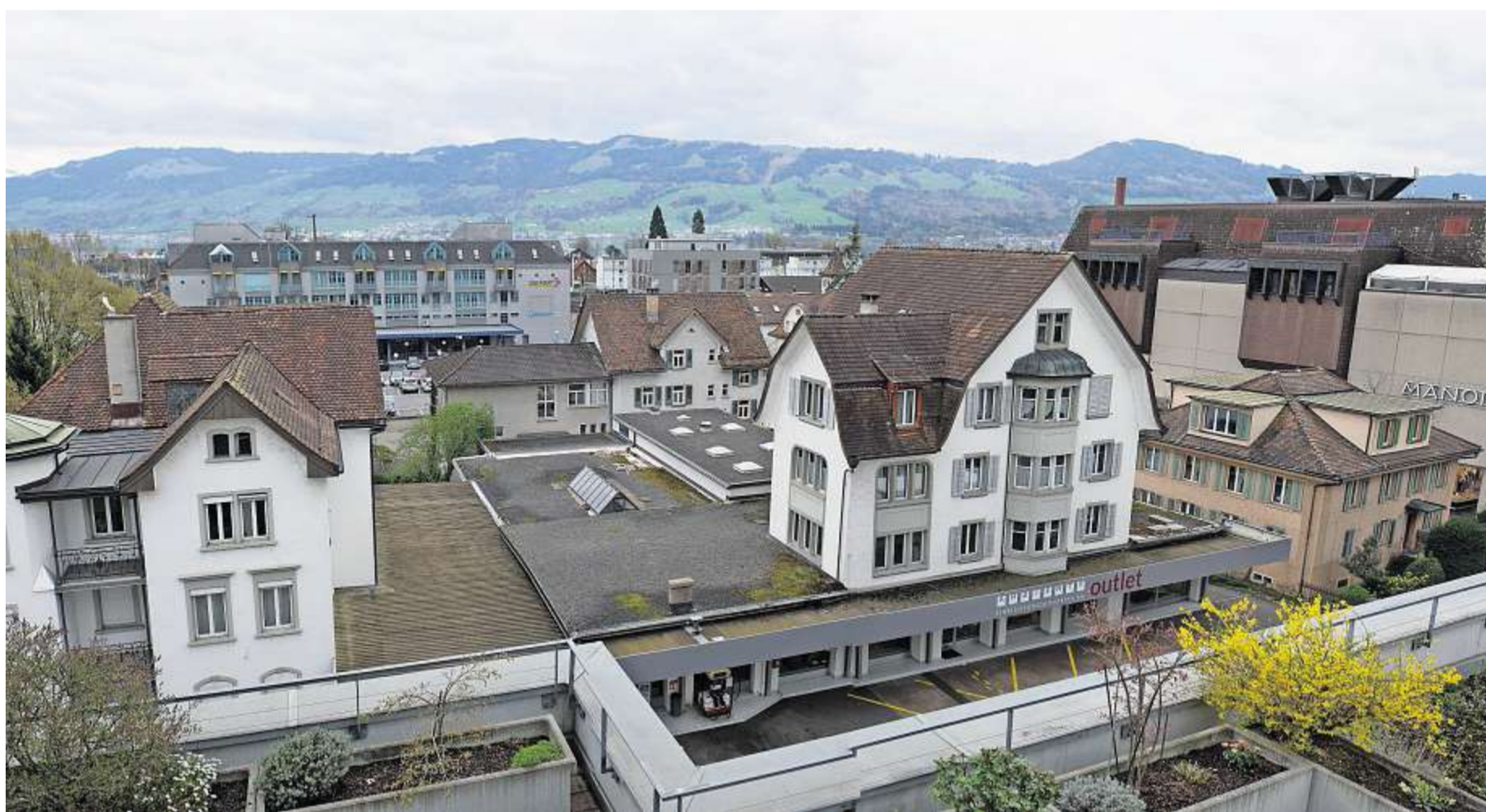
Sicht vom Albuville aus: Südlich der Neuen Jonastrasse werden ältere Häuser abgerissen, um Platz zu schaffen für das Citycenter-Projekt. Rechts im Bild Manor, im Hintergrund die Post. Manuela Matt
