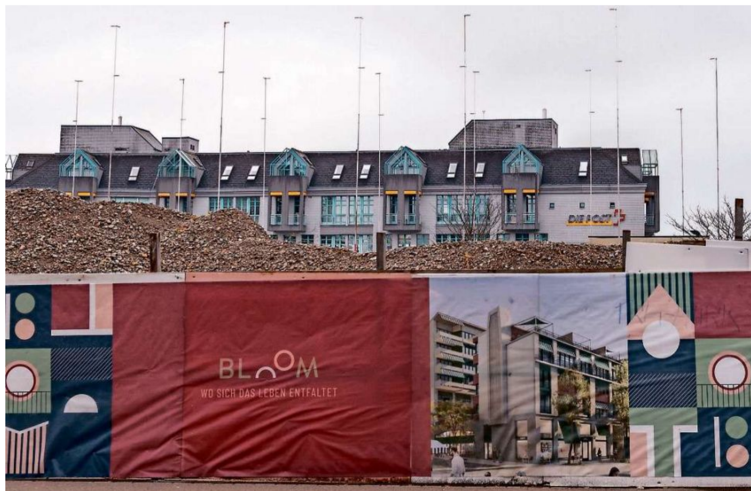
Etwas Farbe: Weil die Baulücke im Rapperswiler Zentrum noch länger bestehen dürfte, hat die Bauherrschaft kürzlich die Sichtschutzwände verkleidet. Bild Pascal Büsser
