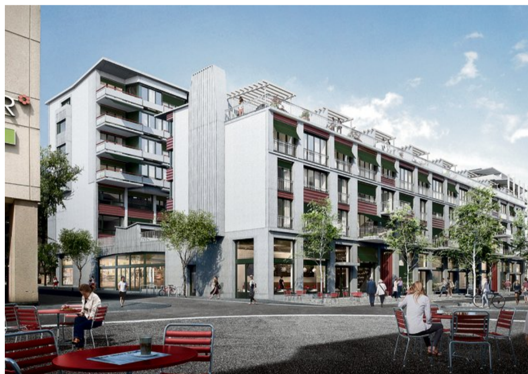
Blick auf die Merkurstrasse und das Citycenter vom Platz des alten Feuerwehrdepots.
