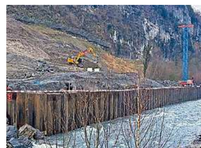
Wieder frei: Die Bagger haben ihre Arbeit erledigt.
