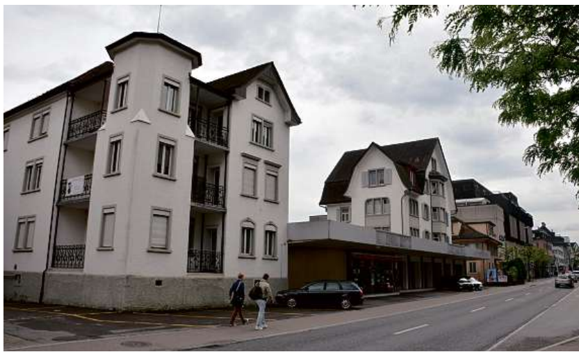
Kommen weg: Die weissen Häuser sind zwei der insgesamt fünf, die abgerissen werden für die neue Grossüberbauung Citycenter.
