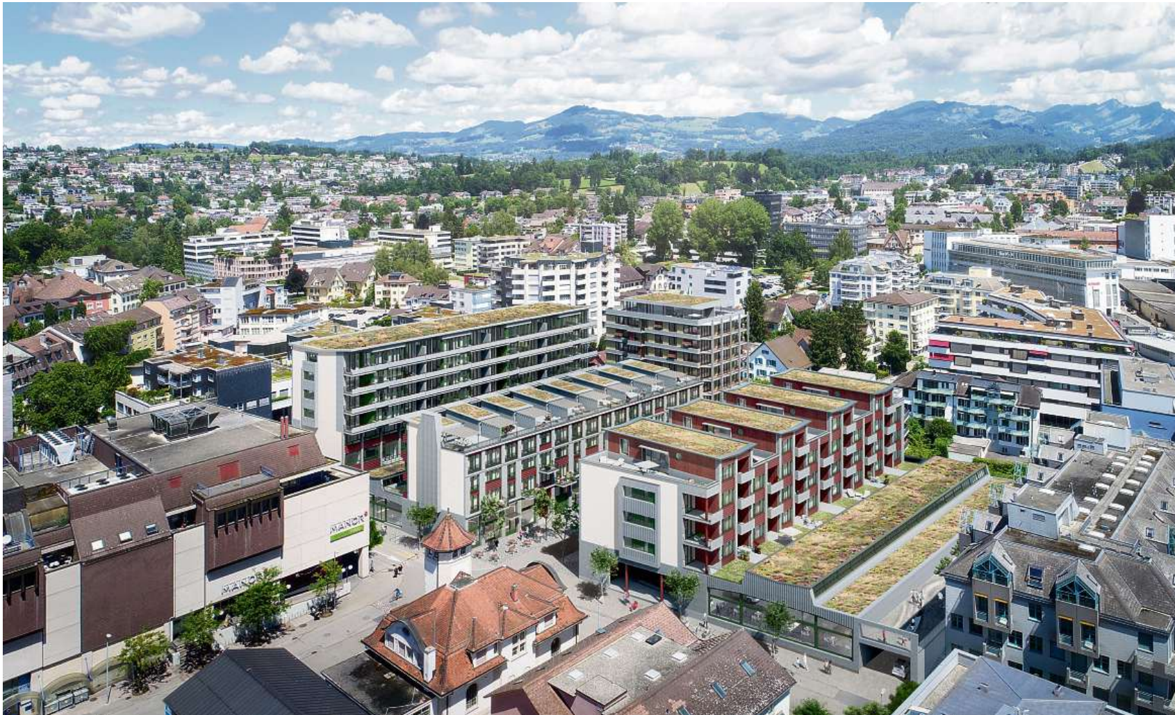
Bauten statt Parkplatz: Die zwei abgestuften Baukörper des Citycenters (Mitte) sowie das Saweka-Gebäude dahinter verändern das Gesicht der Rapperswiler Neustadt. Visualisierungen zVg
